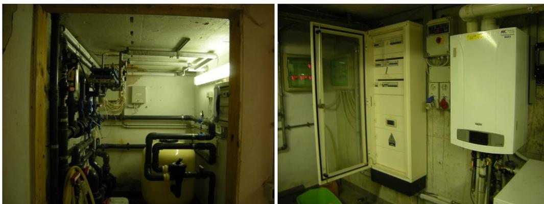
Va evidenziato che nonostante gli impianti siano certamente moderni, nel senso che sono state utilizzate delle soluzioni tutt'ora in uso come le pompe di calore e le sonde geotermiche, l'abitazione non ha il cappotto esterno ma solamente una muratura a cassetta con isolamento interno.
