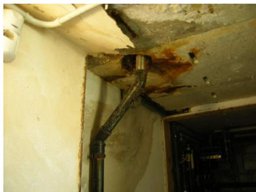
Infiltrazioni d'acqua e degrado delle parti metalliche
